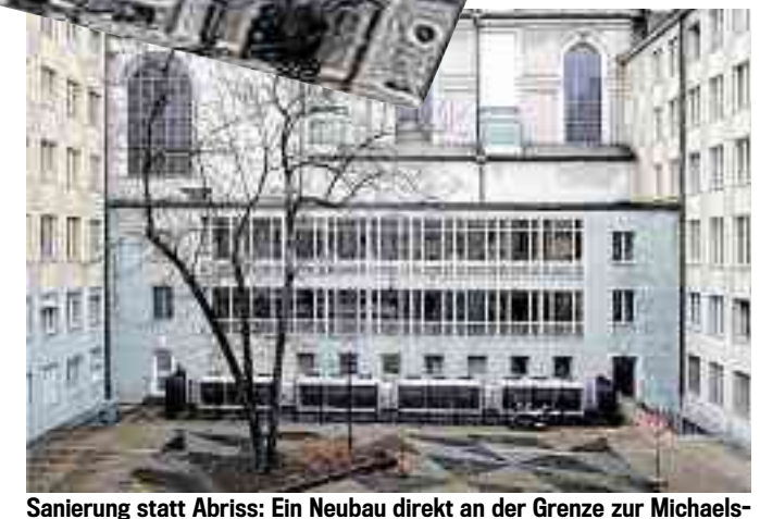
Sanierung statt Abriss: Ein Neubau direkt an der Grenze zur Michaelskirche würde niemals genehmigt.
