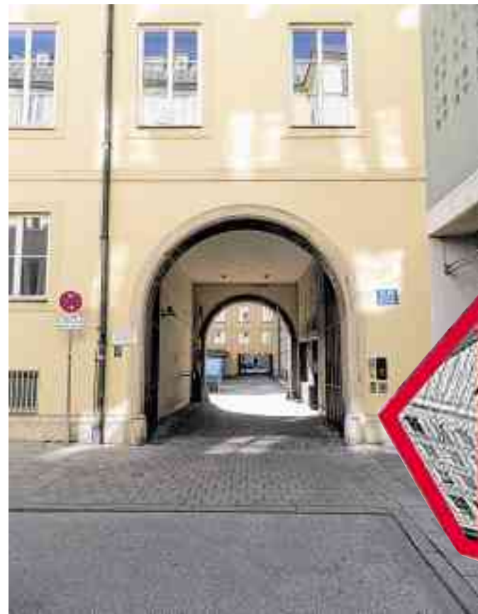
Die Zufahrt zum Innenhof hat nur eine Höhe von 2,65 Metern - zu schmal für schwere Baufahrzeuge. Fotos: www.ibbmuenchen.de
